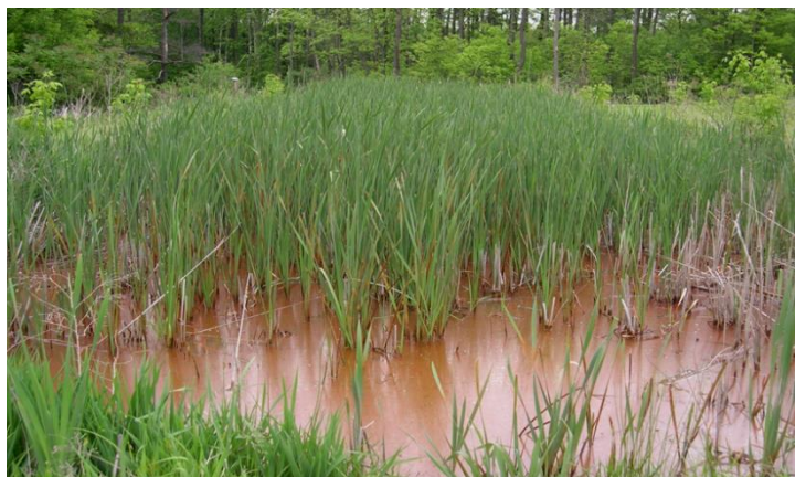
Obrázek 4. Umělý mokřad pro čištění alkalických důlních vod. Monastery Run, Pensylvánie.
