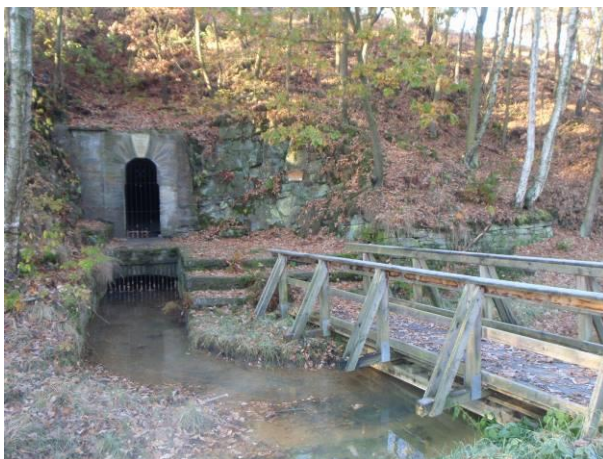
Abbildung 19: Mundloch des HSU mit Grubenwasseraustritt.
