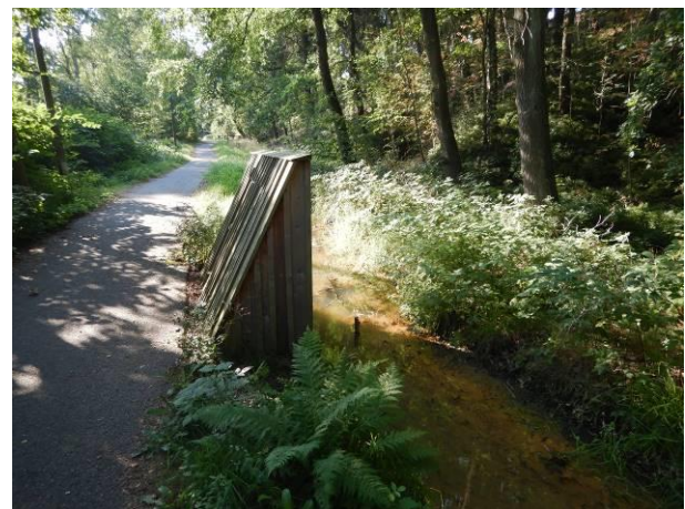
Abbildung 20: Abschlag des Roten Grabens unterhalb des HSU.
