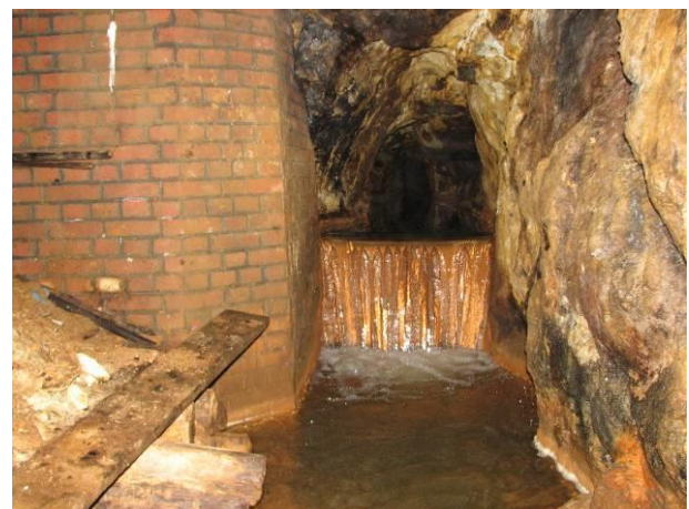
Abbildung 14: Sohlschwelle oberhalb des Mundlochs des Verträgliche Gesellschaft Stollns
