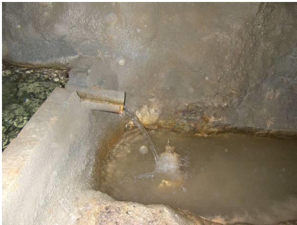
Abbildung 11: Sohlschwelle mit Sedimentationsstrecke am Damm 1 Tiefer Hilfe Gottes Stolln.
