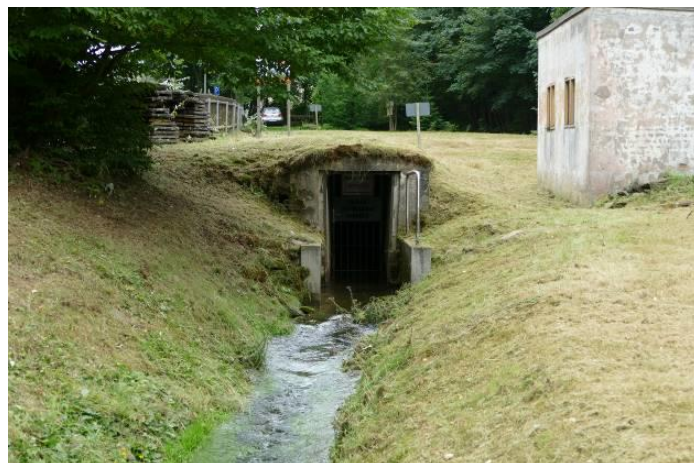
Abbildung 26: Mundloch des Tiefen Sauberge Stollns.
