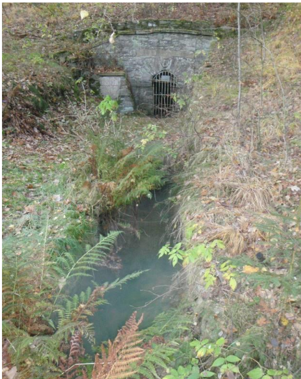
Abbildung 17: Mundloch des VGS mit Grubenwasseraustritt.
