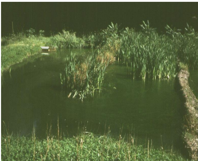
Umělý mokřad Lick Run, Ohio, USA – aerobní mokřad osázený Typha latifolia .
