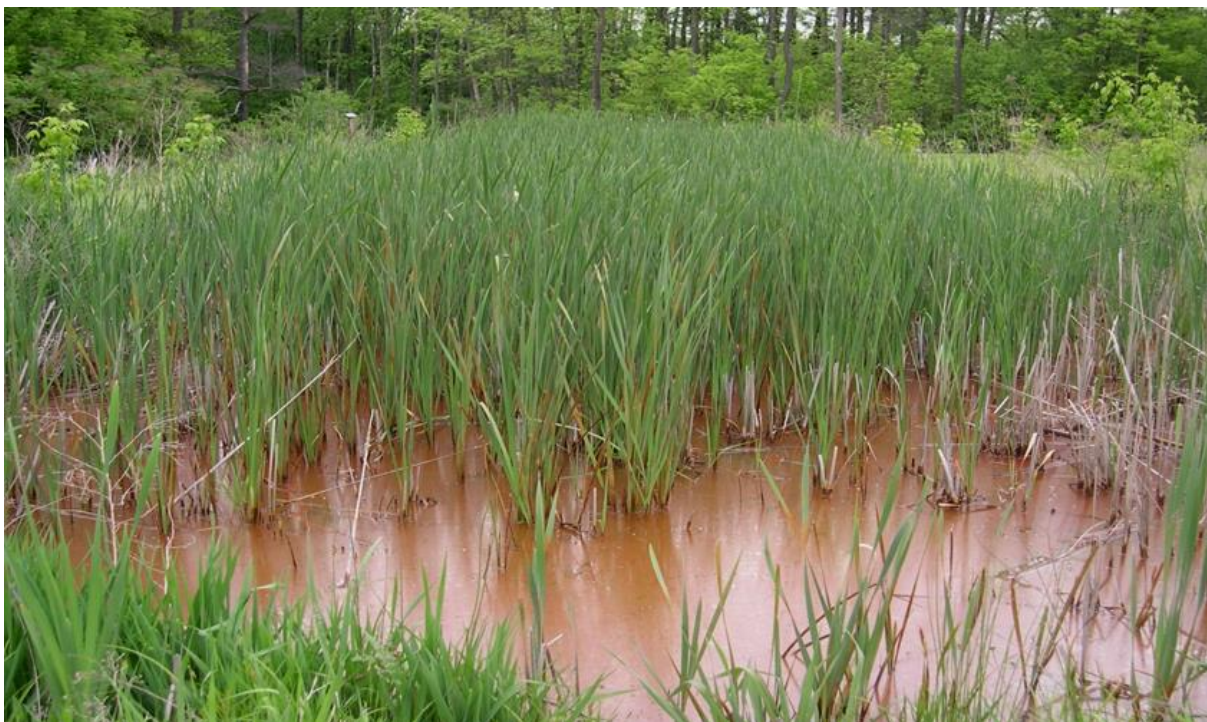
Obrázek 7. Umělý mokřad pro čištění alkalických důlních vod. Monastery Run, Pennsylvánie.
