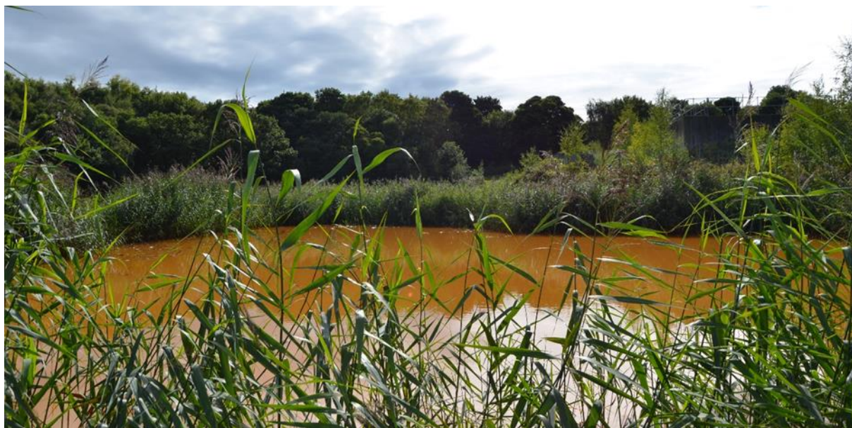
Obrázek 10. Vyrovnávací nádrž na čistírně Hope Pit, která je navržena pro čištění důlních vod.
