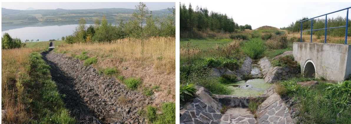
Obrázek 2. Příklady umělých stok, příkopů a odvodňovacích kanálů
