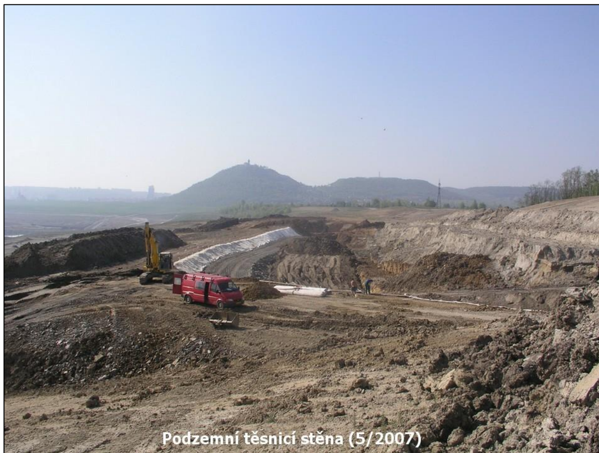
Obrázek 6. Výstavba podzemní těsnicí stěny v roce 2007
