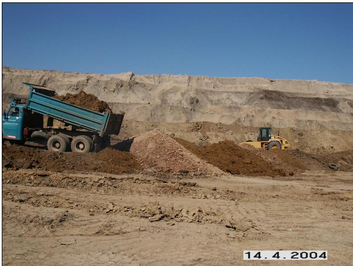
Obrázek 4. Sanační práce ve zbytkové jámě lomu Ležáky-Most v roce 2004
