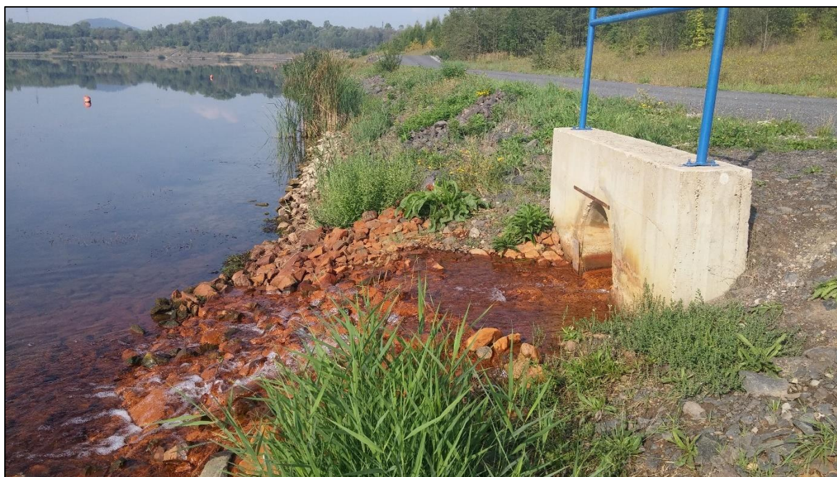
Obrázek 60. Výtok z přelivového vrtu č. 9 do jezera Milada
