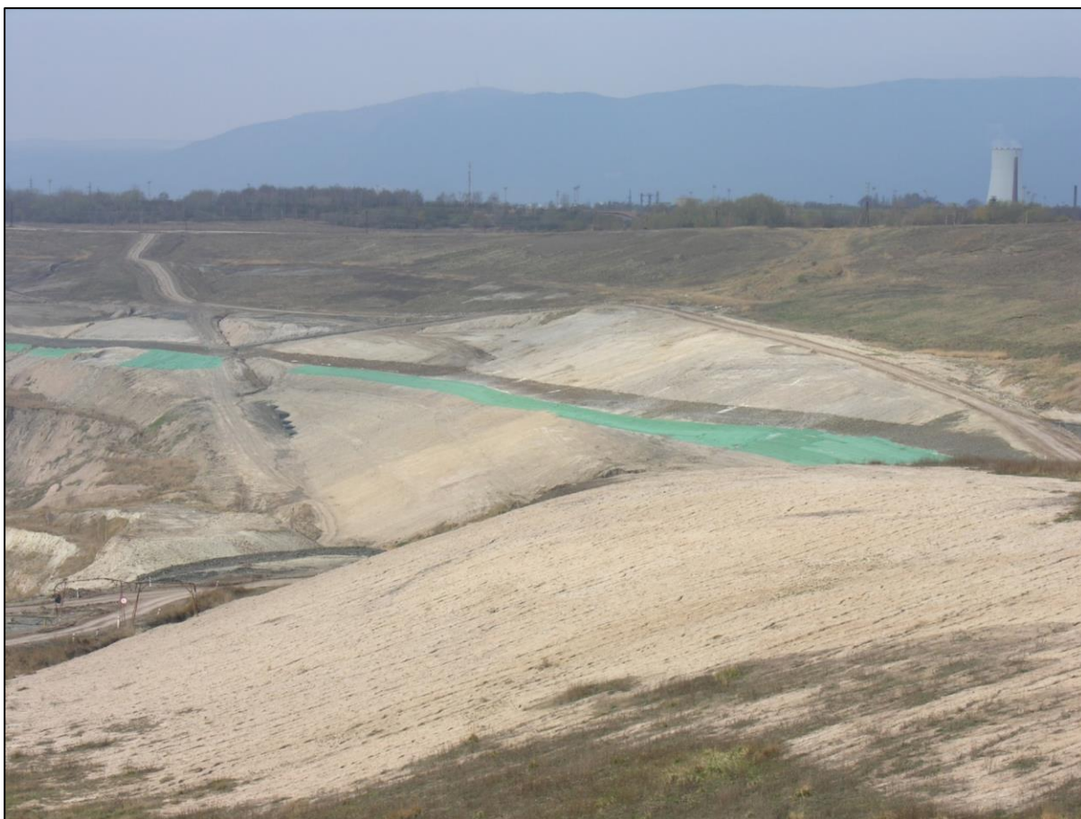
Obrázek 5. Opevnění břehové linie ve zbytkové jámě lomu Ležáky-Most v roce 2008
