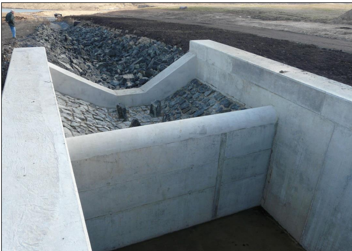
Obrázek 8. Uklidňovací nádrž na konci přivaděče
