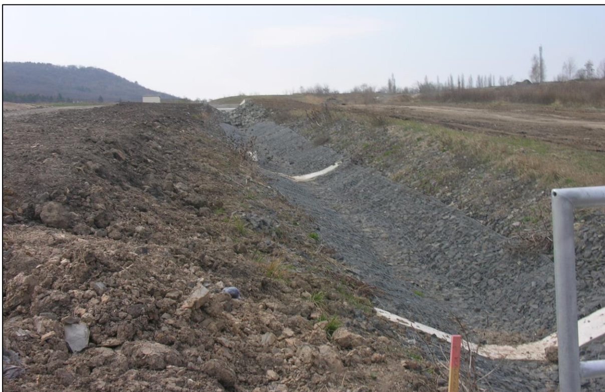
Obrázek 9. Přívodní kanál od uklidňovacího objektu do jezera v roce 2008
