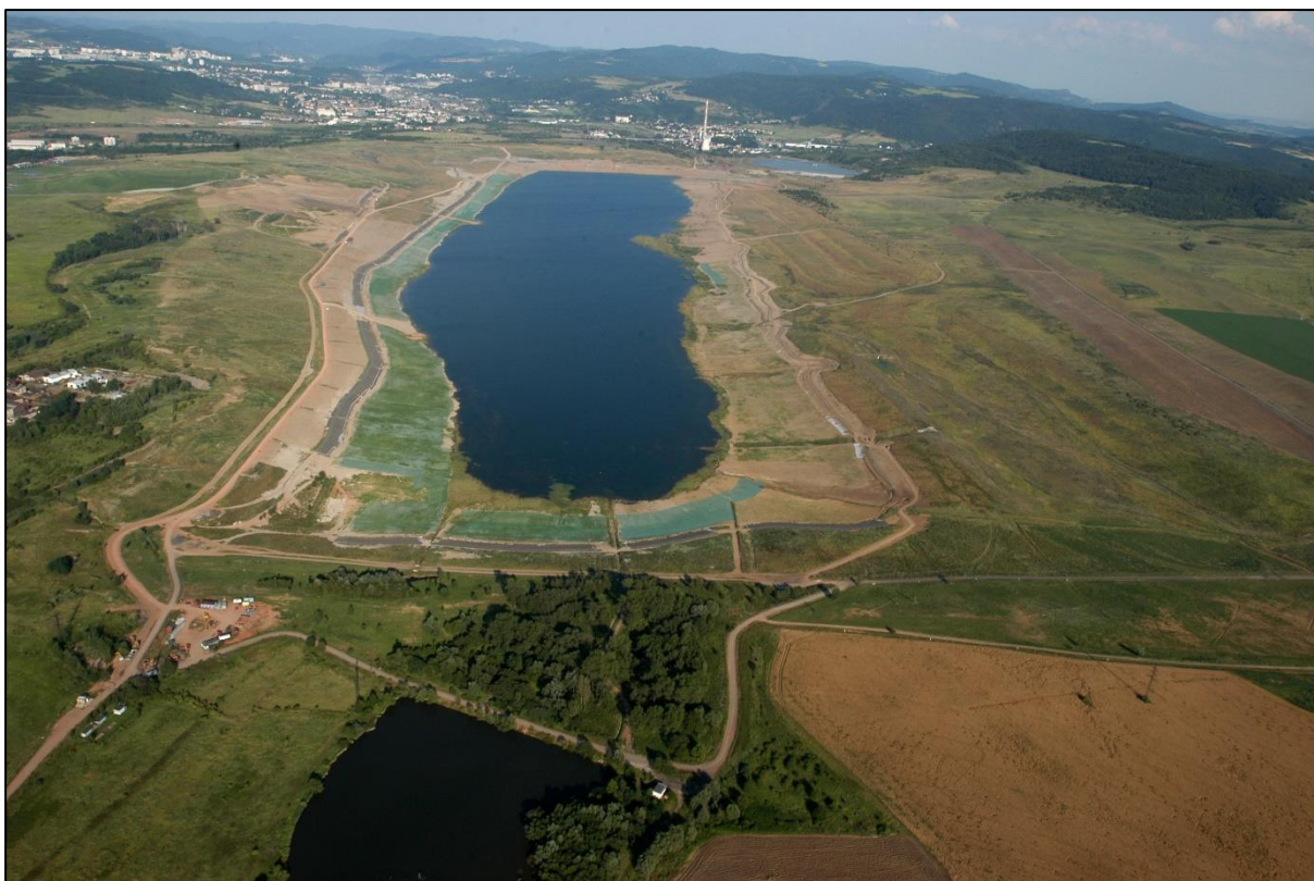
Obrázek 61. Opevnění břehové linie zbytkové jámy lomu Chabařovice
