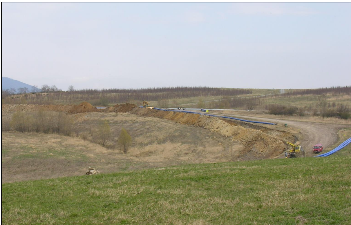
Obrázek 10. Výstavba přivaděče z MR 1 v roce 2008
