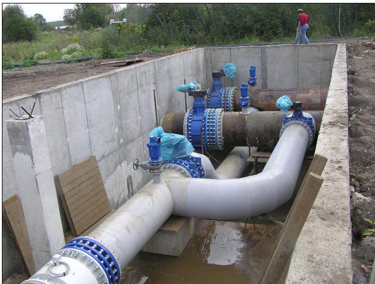
Obrázek 7. Napojení přivaděče na PVN v rozdělovací šachtě
