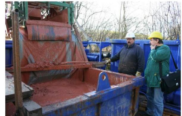
Bild 9: Beprobung des Bohrgutes aus der Bohrspülung (06.11.2013)
